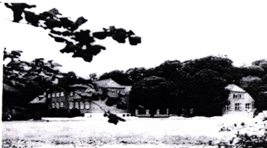
Viby skole som den så ud efter om-og tilbygningen 1939-40.
